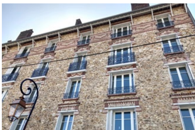
Transformation d'un immeuble de 11 logements en 22 logements réhabilités à Enghien-les-Bains (95).
