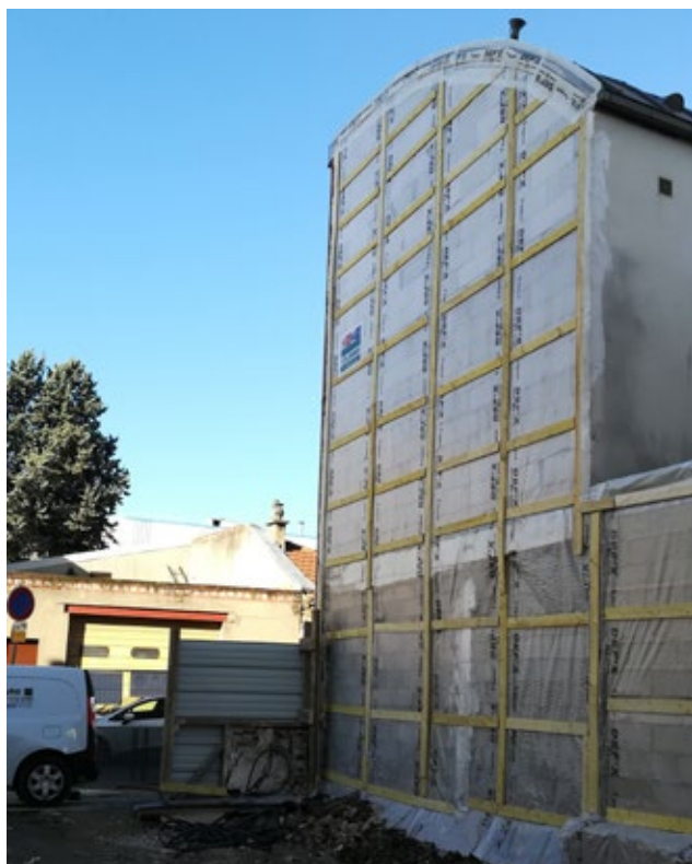
Construction de 8 logements collectifs sociaux à Montreuil (93).
