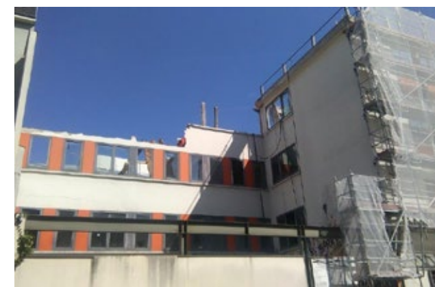
Création d'une pension de famille de 25 logements à Paris (75).
