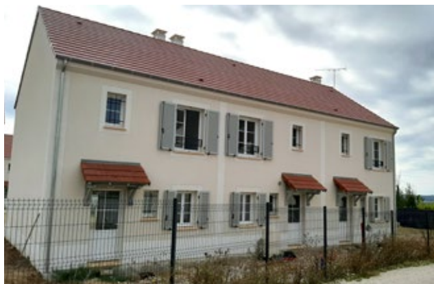
Construction en VEFA de 3 logements T4 à Beynes (78).
