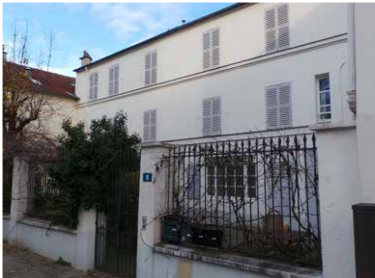
Logements copropriété impasse Girardon – Paris 18.
