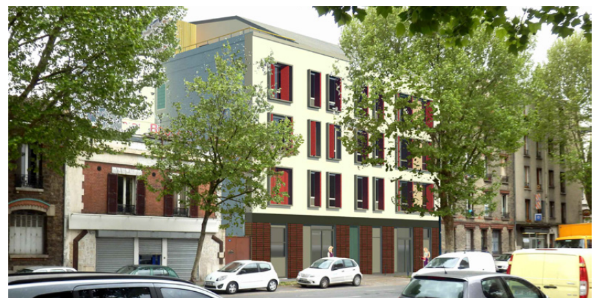
La façade de la future structure sociale de Pantin.
